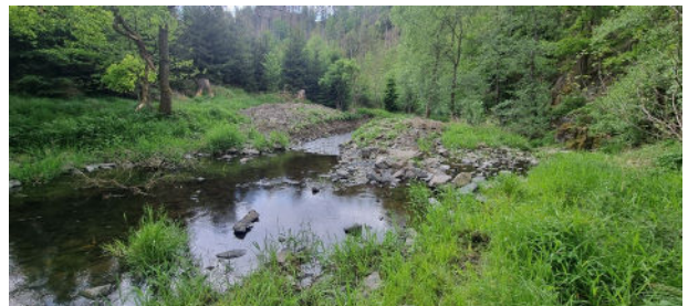
Sohlstufe Dörflas 1 nach Umbau (Mai 2025)
