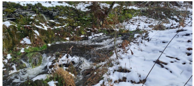
Sohlstufe Dörflas 1 vor Rückbau (Dezember 2023)
