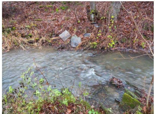
Sohlstufe Ziegenrück 2 nach Rückbau (Dezember 2024)
