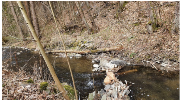
Sohlstufe Ziegenrück 2 vor Rückbau (März 2022)
