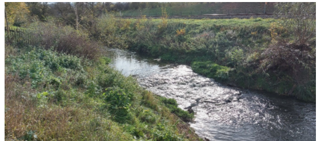
Sohlstufe Köstitz 3 vor Maßnahmenumsetzung (September 2022)
