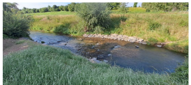
Sohlstufe Köstitz 3 nach Maßnahmenumsetzung (August 2023)
