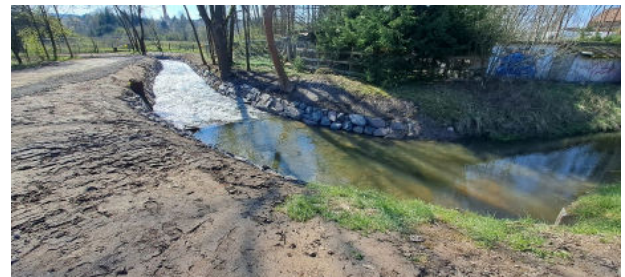
Sohlstufe Köstitz 4 nach Maßnahmenumsetzung (April 2023)
