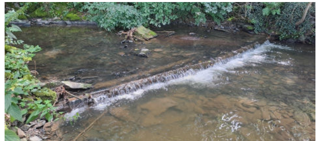
Sohlstufe Kupfermühle 2 vor Maßnahmenumsetzung (August 2023)
