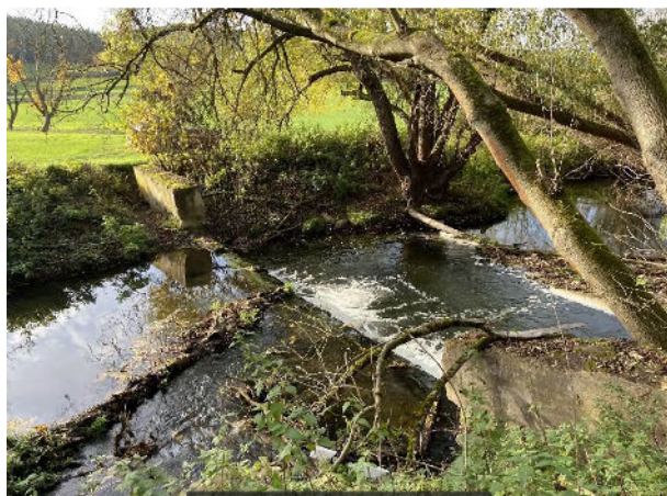
Orla im Abschnitt 10, Stützschwelle nörd. Schweinitz (ID 8657) oberhalb Kleindembach vor Umsetzung
