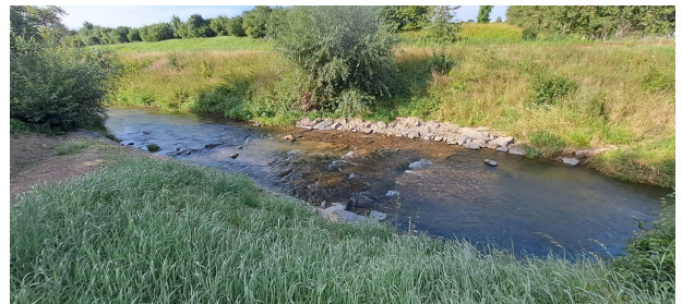
Sohlstufe Köstitz 3 nach Maßnahmenumsetzung (August 2023)
