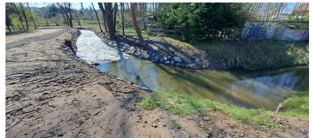
Sohlstufe Köstitz 4 nach Maßnahmenumsetzung (April 2023)
