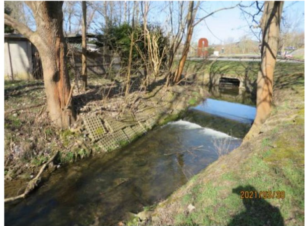
Sohlstufe Köstitz 4 vor Maßnahmenumsetzung (März 2021)
